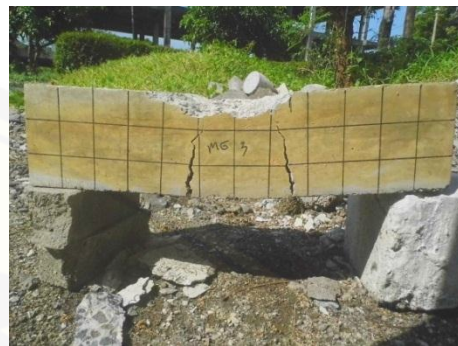
Gambar 4.14 pola retak balok MG 3
