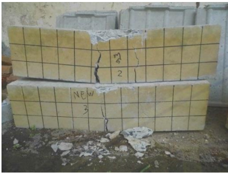
Gambar 4.13 pola retak balok MG 2
