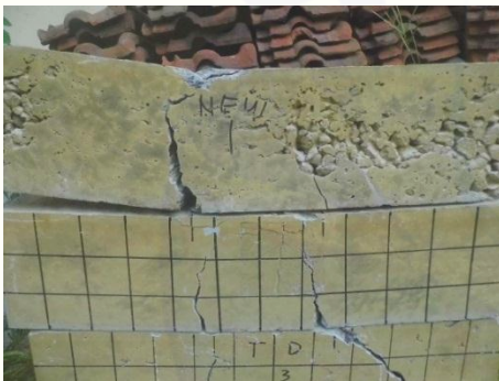
Gambar 4.9 pola retak balok NEW 1
