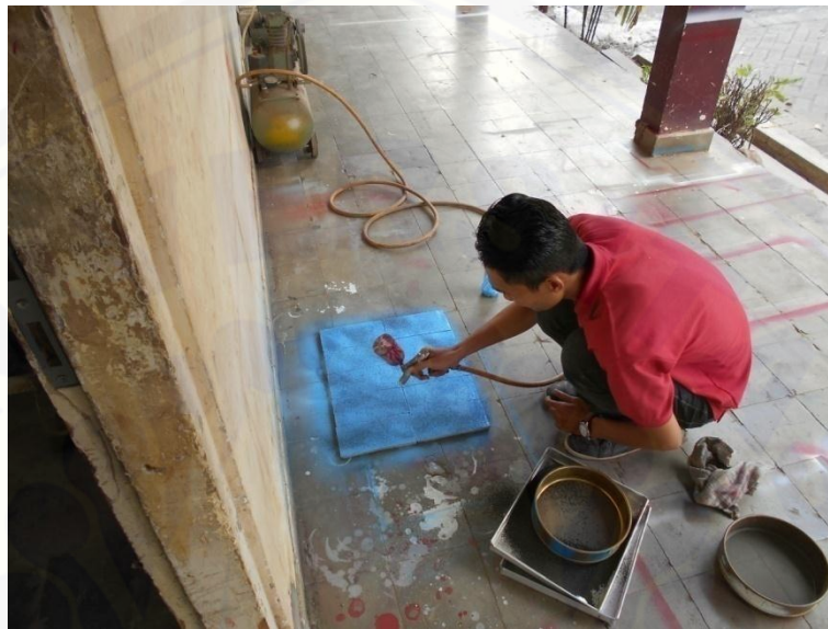
Gambar A 11. Proses finishing menggunakan cat
