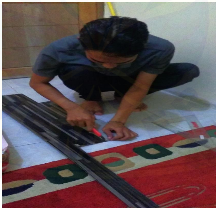
Gambar A 12. Proses finishing menggunakan HPL
