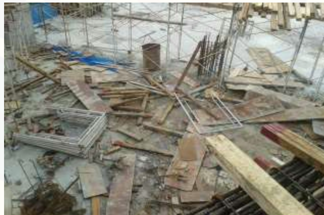
Gambar 4.2 Banyaknya paku atau benda tajam lainnya berserakan di area kerja.
