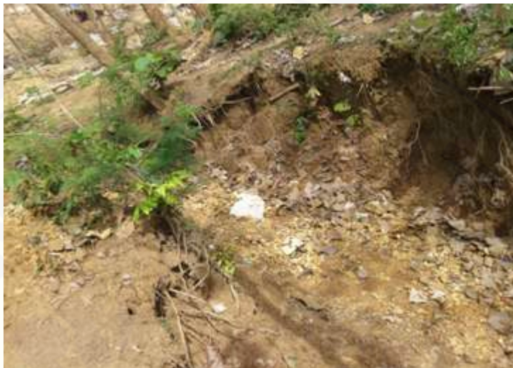
Longsor di sudut-sudut lereng
