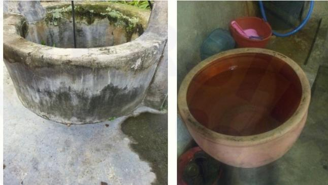
Gambar 4.5 Kondisi fisik sumur gali dan bak penampungan air
