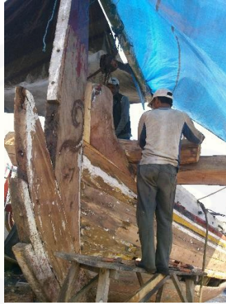
Gambar 4.17 Penggantian bagian perahu yang rusak
