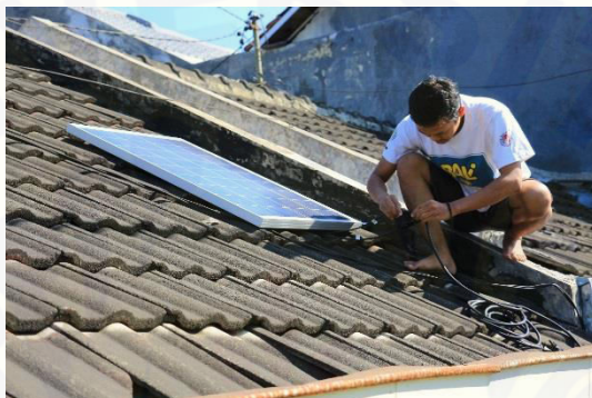
Pemasangan PV panel dengan sudut kemiringan mengikuti atap rumah
