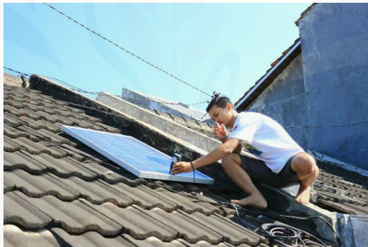
Pengukuran irradiance yang jatuh ke PV panel
