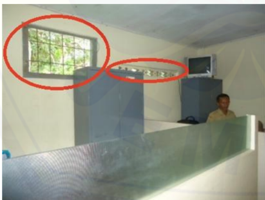
Gambar 15. Ventilasi di ruang kerja kantor kelurahan Antirogo
