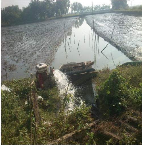
Pompa untuk menguras air pada persiapan penggalangan lahan
