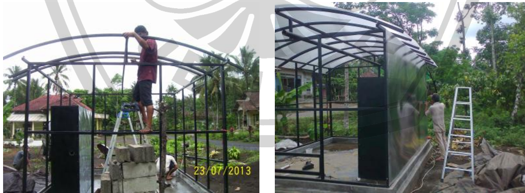
Gambar 6. Perakitan Bangunan Pengering Efek Rumah Kaca
