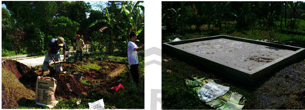
Gambar 5. Pekerjaan Lantai Bangunan Pengering Efek Rumah Kaca
