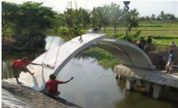
Gambar 2.1 Beton precast untuk jembatan di lapangan
