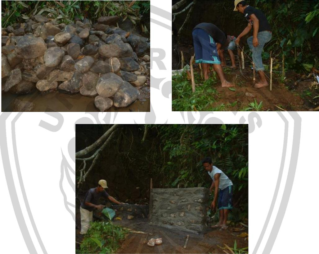
**Gambar 5.** Pekerjaan Pondasi Generator dan Kincir PLTMH
