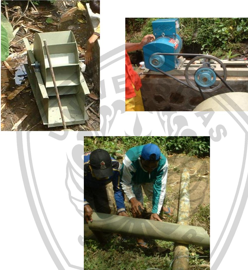
**Gambar 6.** Perakitan Perakitan Pembangkit Listrik Mikro Hidro (PLTMH)
