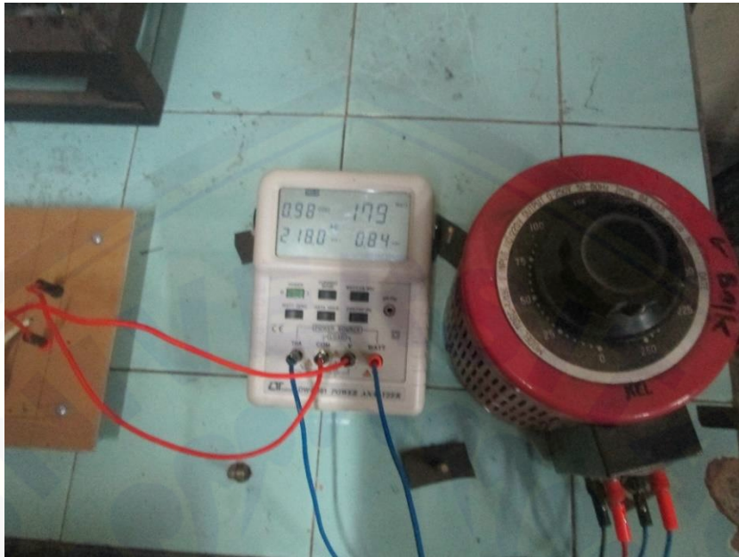
Pengujian tanpa beban motor rewinding pada tegangan 220 V
