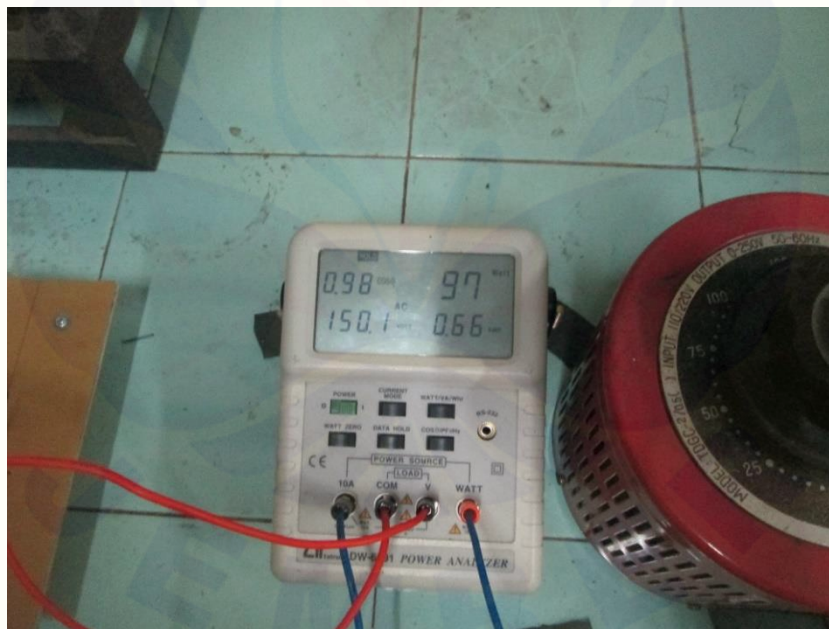
Pengujian tanpa beban motor rewinding pada tegangan 150 V
