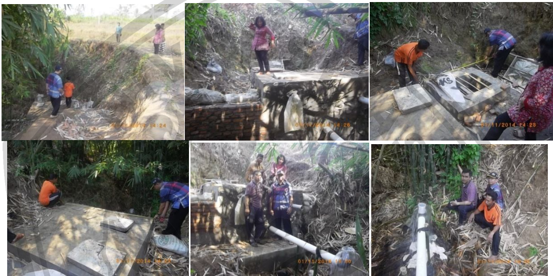
Pengukuran dimensi bangunan penyaringan dan bangunan pengambilan
