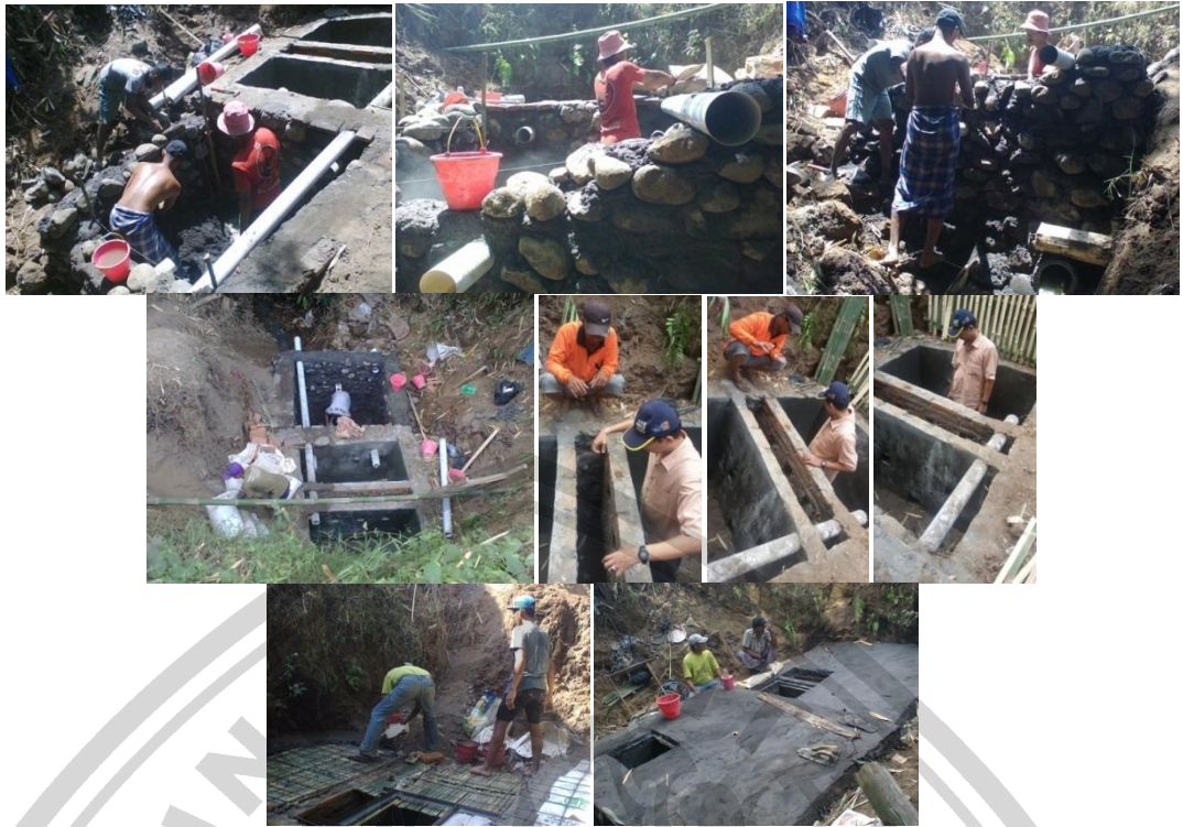
Pelaksanaan pembangunan bangunan penyaringan dan bangunan pengambilan sumber air desa darungan
