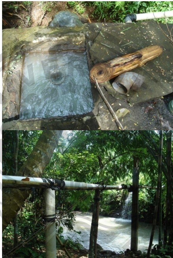
Gambar 1. Sumber pengambilan air dan pipa penyalur air kebutuhan rumah tangga.
