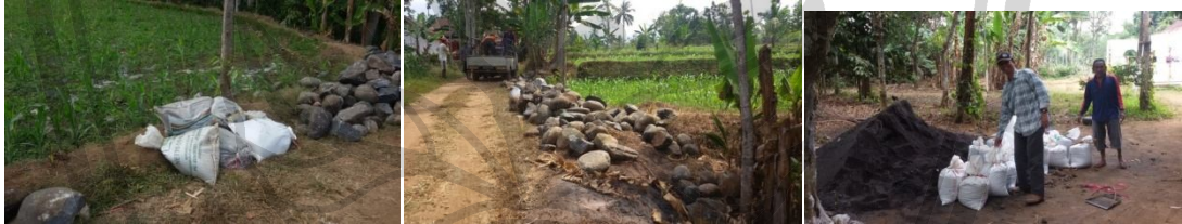
Penyiapan material batu kali dan pasir untuk di transportasikan ke lokasi bangunan pengambilan di sumber air.
