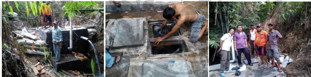
Uji coba pengisian bak penyaringan dan bak penampungan air sumber
