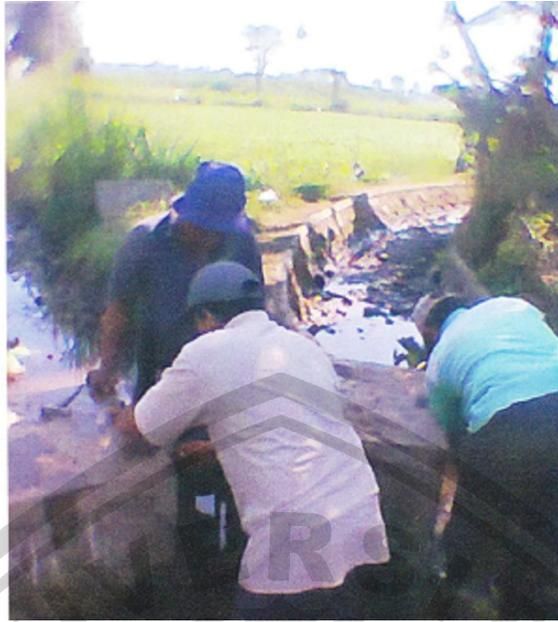
Gambar 5.2 Pembongkaran dan pemasangan rangka pintu air
