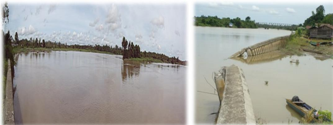
Gambar 4. Segmen belokan Sungai Jelarai dan kondisi sheet pile di sisi tebing belokan luar, 2014.
