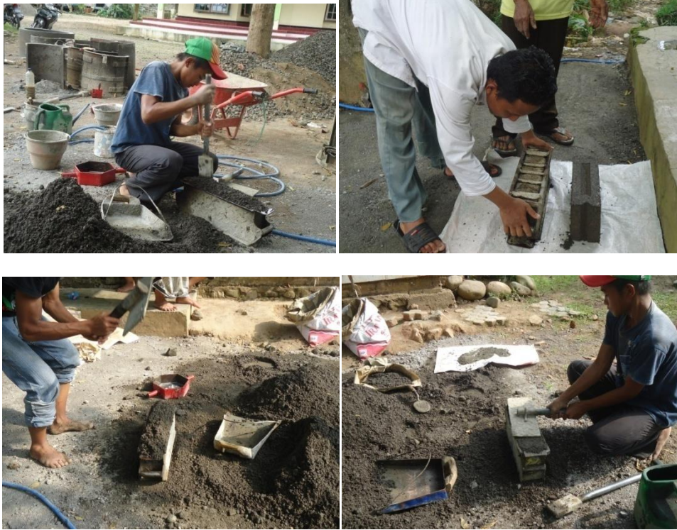
Gambar 7 Praktek Pembuatan Batako
