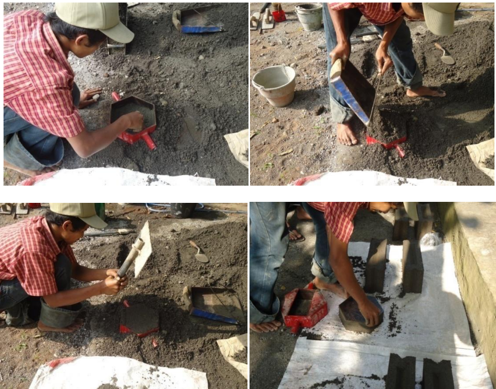
Gambar 7 Praktek Pembuatan Batako
