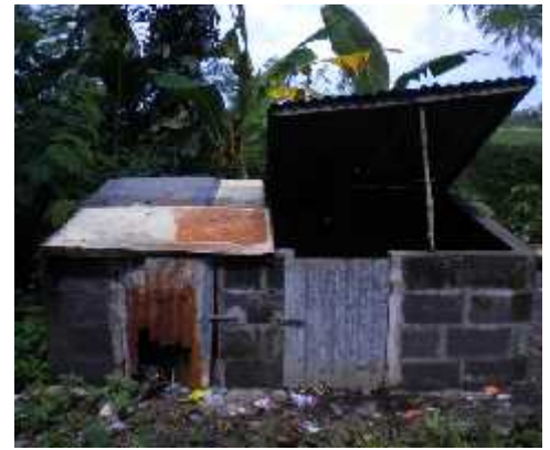
Gambar 16. Kontainer (TPS) untuk menampung sampah medis dari ruang perawatan
