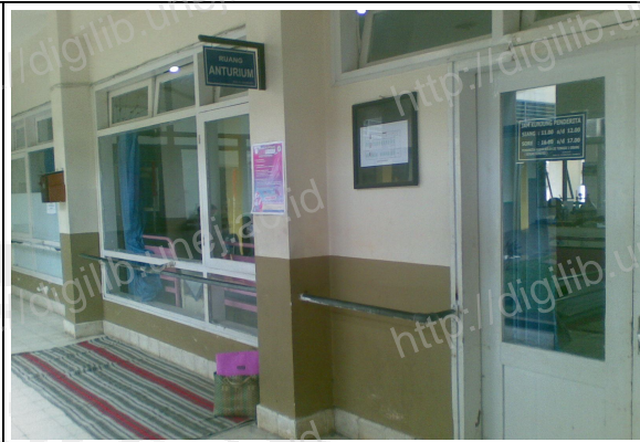
Ruang Interna Pria Tampak Depan
