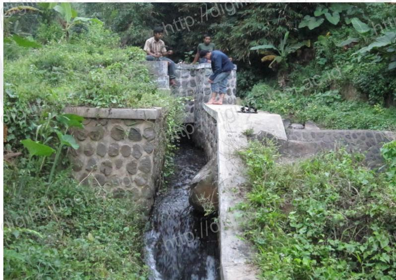
Gambar 4.4 Bangunan bendung yang digunakan sebagai intake tampak belakang
