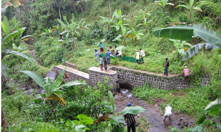
Gambar 4.3 Bangunan bendung yang digunakan sebagai intake tampak depan
