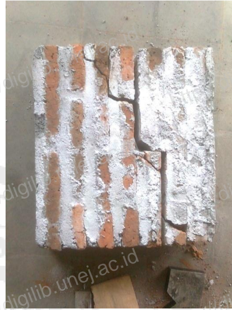
Gambar 16 Keretakan Akibat Kuat Geser
