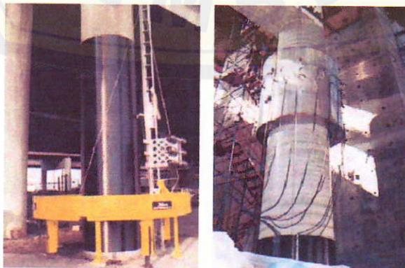
Gambar 2.7 : Mesin alat pemasang CFRP kolom bulat (Perumalsamy, 2009)
