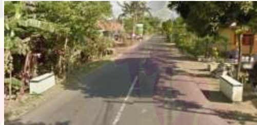
Gambar 4. 16 Kondisi Gorong-Gorong pada Tipe Jalan 2/2 UD
