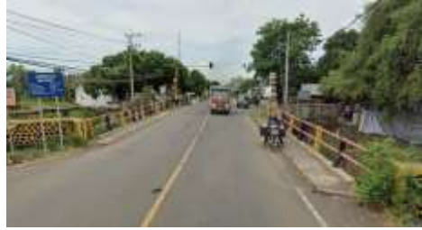
Gambar 4. 15 Kondisi Jembatan pada Tipe Jalan 2/2 UD
