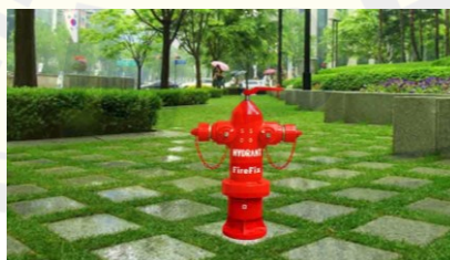
Gambar 4.47 Preseden Instalasi Hidran Kebakaran (Sumber: firehydrant.id)
