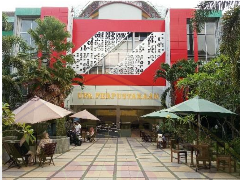
Gambar 4. Foto bangunan perpustakaan pusat Universitas Jember
