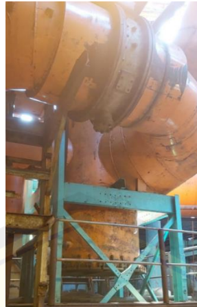
Gambar 2.3 Vapour Line Juice Heater (VLJH)
