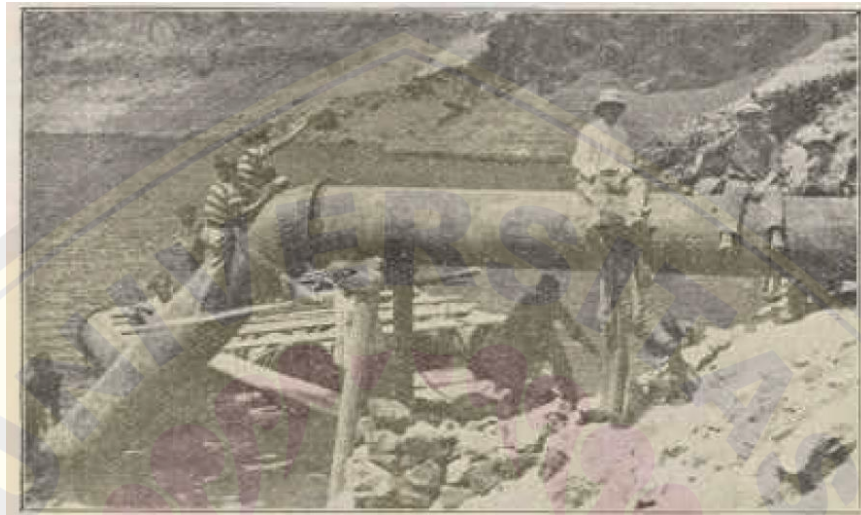
Gambar 4.12 Pemasangan Siphon yang Terdiri dari Pipa dan Terminal Blind pada Danau Kawah
