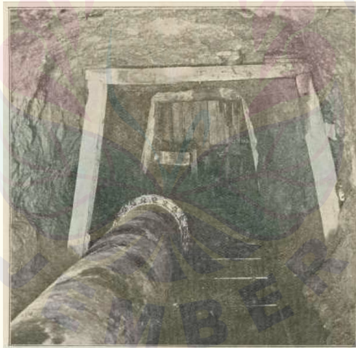
Gambar 4.14 Siphon pada Terowongan V
