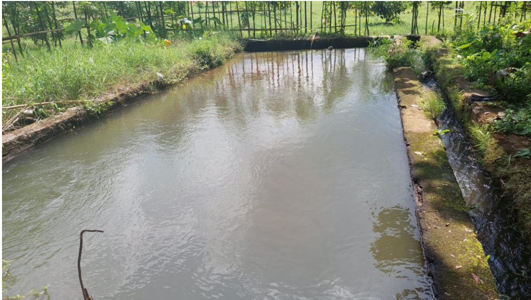
Gambar 4.2 Pipa penenang PLTMh di kawasan Perkebunan Sentool
