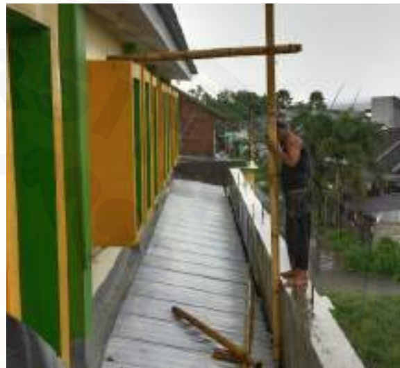
Gambar 7. Proses Pemasangan Talang di Atap Masjid
