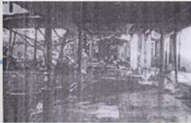
Sumber: KOMRA, 3 Februari 1997 Gambar 1. Pendopo Agung Sasono Sewoko tidak luput dari amukan api
