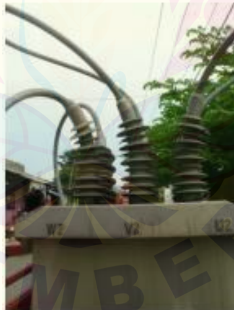
Gambar 2.4 Contoh penempatan bushing recloser sisi beban
