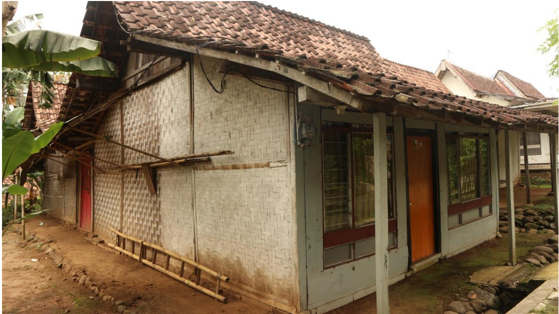
Gambar C.14 Dinding Gedheg Pada Rumah Adat Using Kemiren
