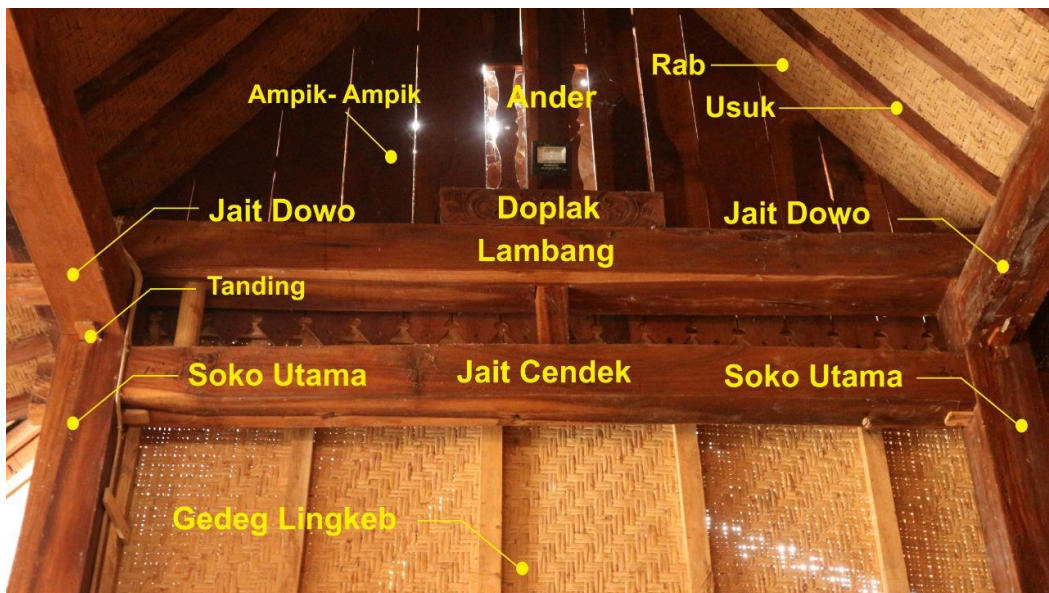
Gambar 5.1 Bagian Rangka Struktur Rumah Adat Using Kemiren (Bagian Dalam) (Sumber Dokumentasi Peneliti)
