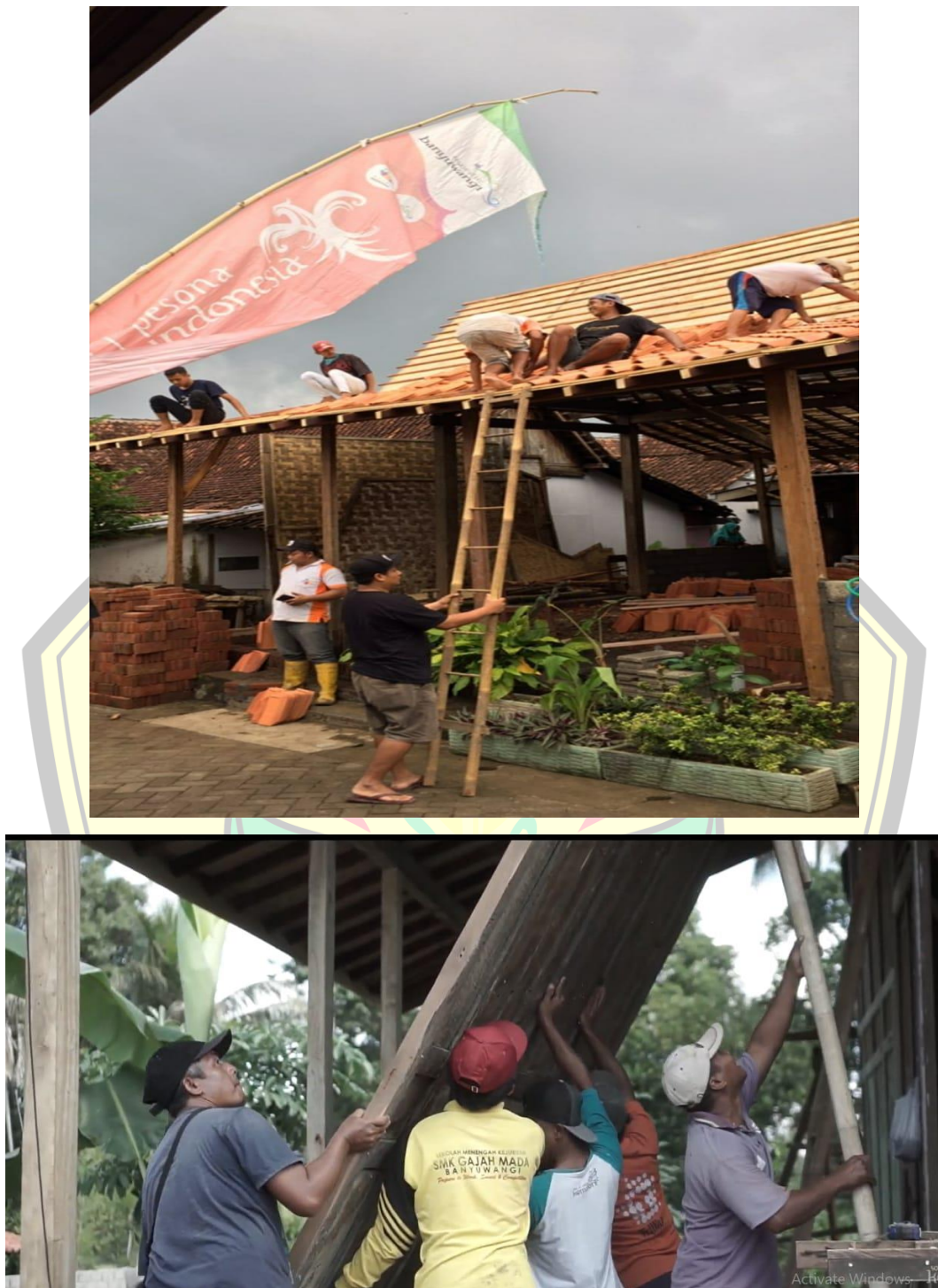
Gambar C.5 Proses Awal Tahap Pembangunan Rumah Adat
