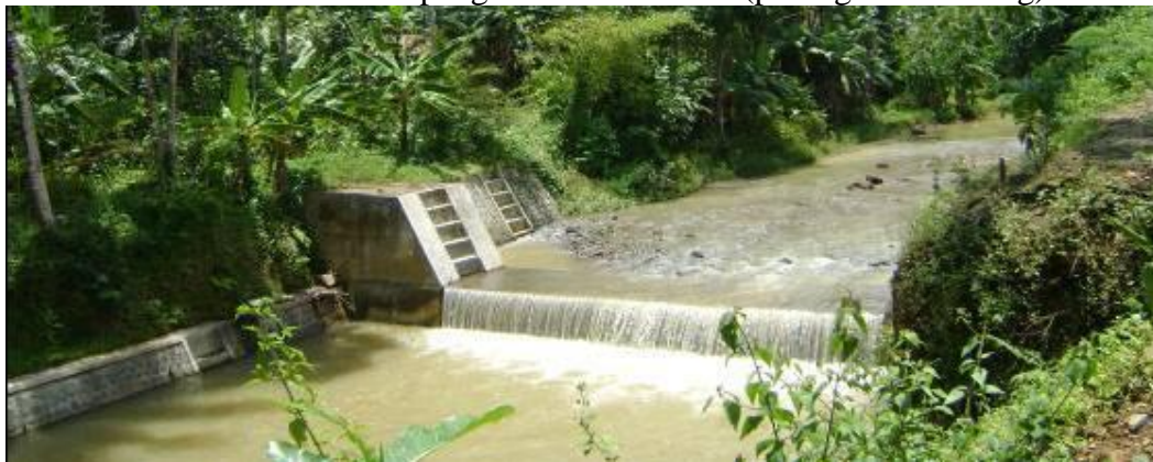
Gambar 2.3 Contoh Sabo Dam pada waduk Mrica-Lumajang
