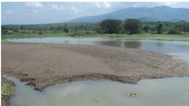
Gambar 4.2 Kondisi sedimen di outlet DAM Sampean Baru
