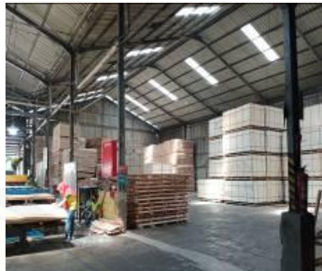
Gambar 6. Jarak antar APAR lebih dari 15 meter
