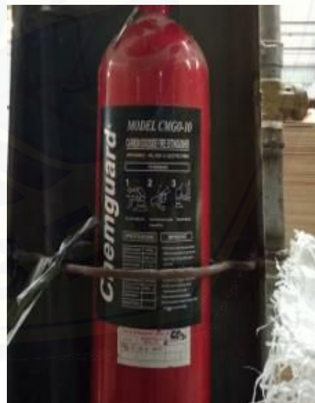
Gambar 16. Label dalam keadaan baik (tidak rusak, bisa dibaca, tidak pudar)
