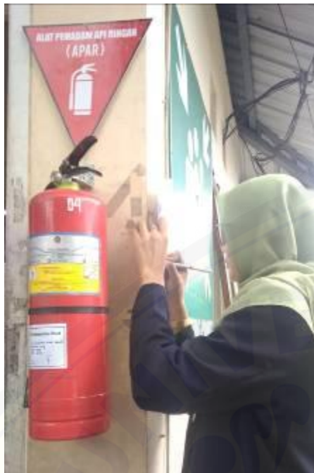
Gambar 25. APAR diletakkan pada posisi yang mudah dicapai dan diambil
