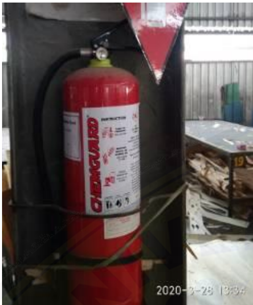
Gambar 13. Tabung tidak berlubang atau cacat karena karat
