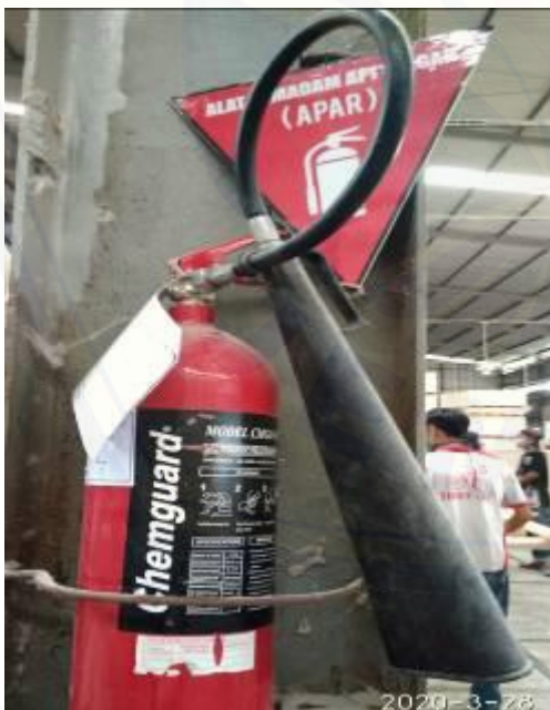
Gambar 19. Pipa pancar tidak retak
