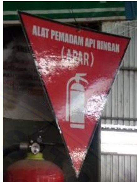
Gambar 22. Tidak memiliki tanda panah dengan tinggi 7,5 cm dan berwarna putih
