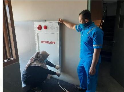
Gambar 6. Proses Pengukuran Ketinggian Peletakan Hidran dari Permukaan Lantai
