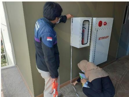
Gambar 7. Proses Pengukuran Ketinggian Peletakan APAR
