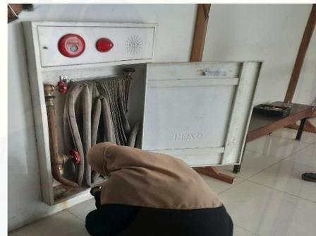
Gambar 8. Pengecekan Kelengkapan Kotak Hidran
