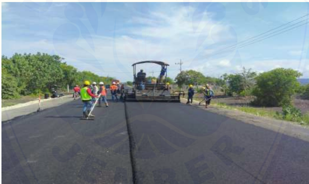
Proses Penghampaan AC – WC oleh Asphalt Finisher
