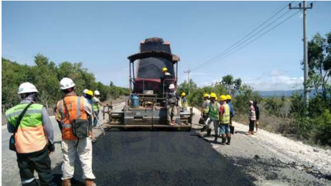
Proses Penghamparan AC – BC oleh Asphalt Finisher
