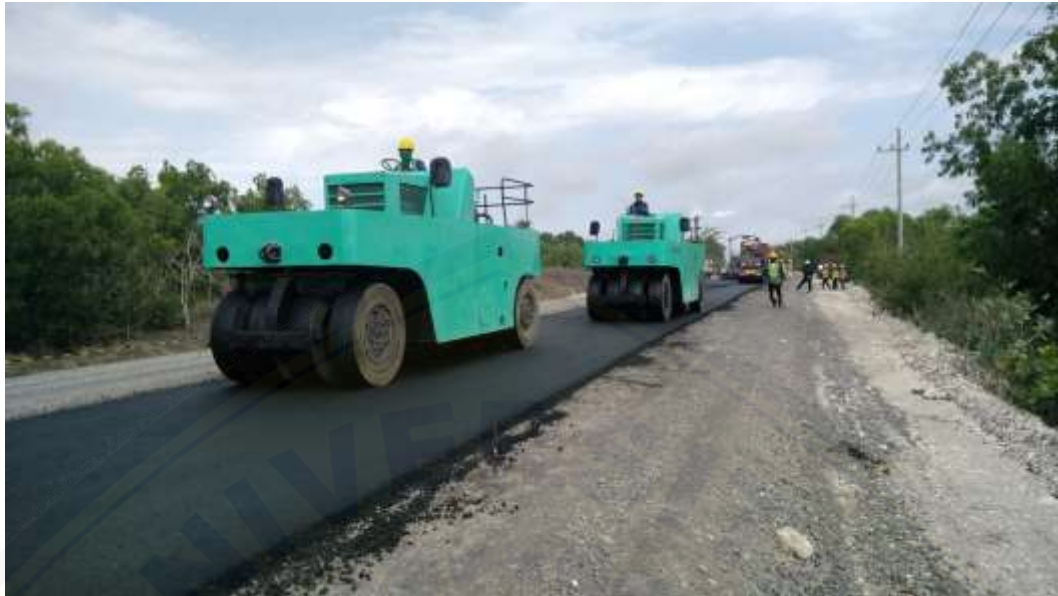
Proses Pemadatan AC – BC oleh Pneumatic Tire Roller
