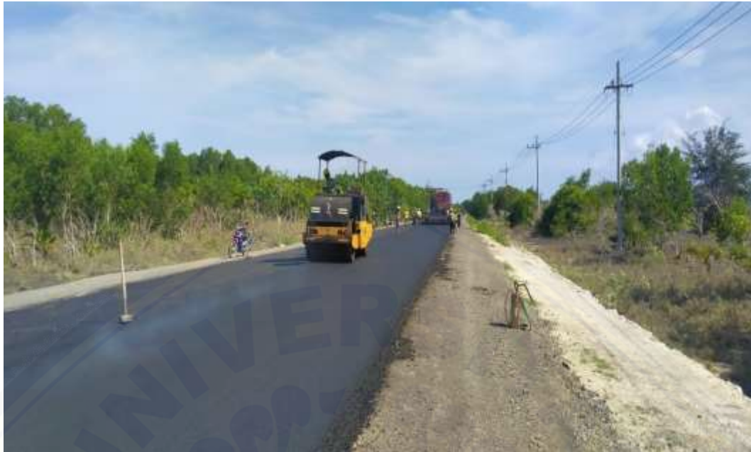
Proses Pemasatan AC – WC oleh Tandem Roller
