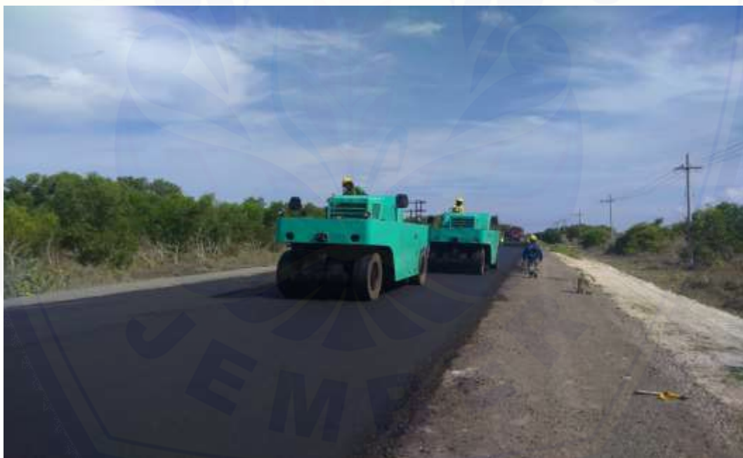
Proses Pemasatan AC – WC oleh Pneumatic Tire Roller
