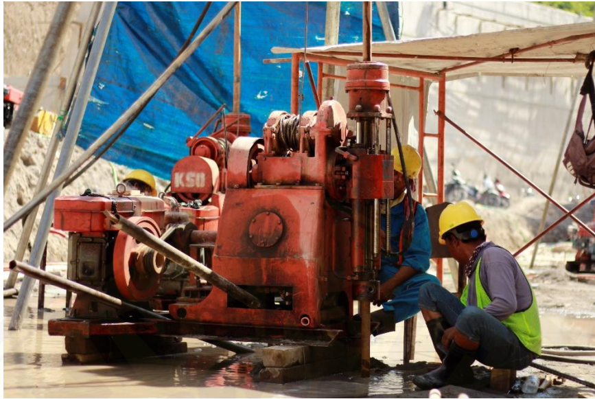
Gambar 2.8 Mesin bor tipe spindle hidrolis
