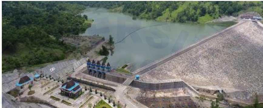
Gambar 2.2 Bangunan bendungan urugan
