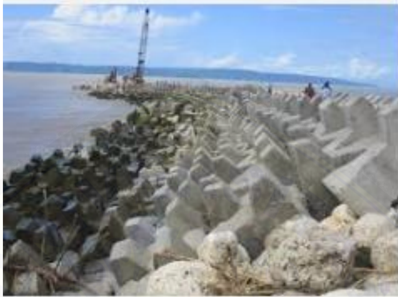
Gambar 3.2 Bangunan Pemecah Gelombang ( Breakwater ) di Pantai Puger
