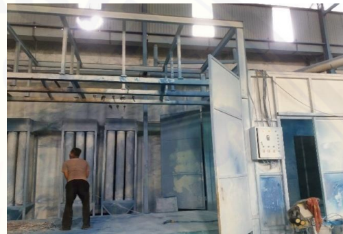
Gambar 15 Proses Pengecatan Powder Coating Sumber : Dokumentasi Pribadi
