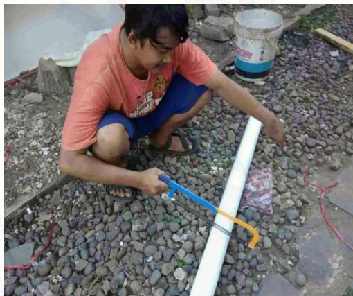
Gambar 3.3 Pemotongan Pipa Pvc 2,5
