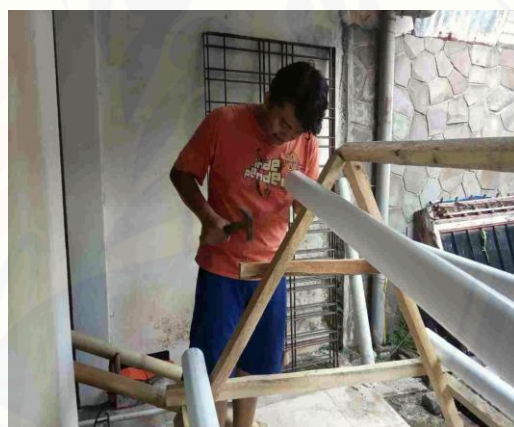
Gambar 3.4 Pembuatan Kerangka DFT
