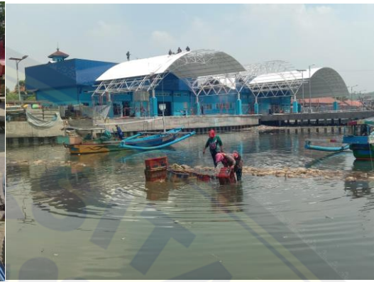
Gambar 6. TPI Puger dalam tahap renovasi
