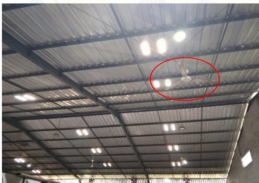
Gambar 12. Atap kerja terbuat dari seng dan terdapat kipas angin
