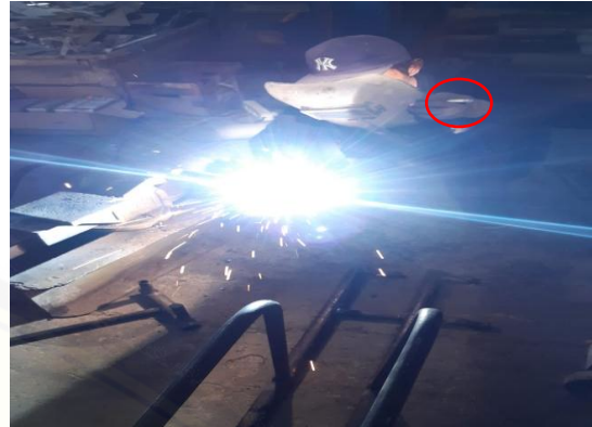
Gambar 18. Pekerja las sambil merokok
