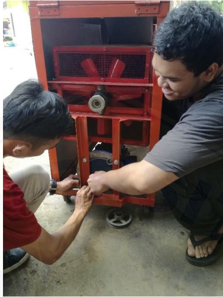
Gambar C.14 Pemasangan Motor Listrik
