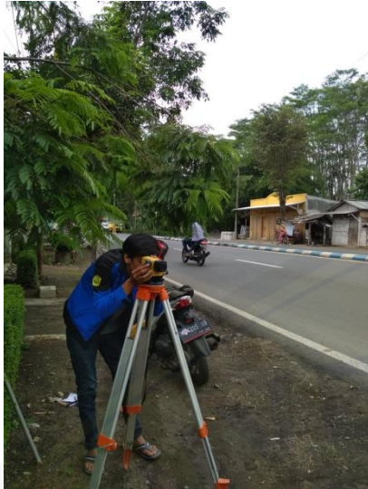
L.1 Pengukuran Elevasi Menggunakan Waterpass
