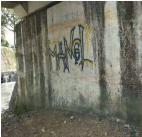
Gambar 3. Kolong jembatan salah satu basecamp responden di Kabupaten Jember
