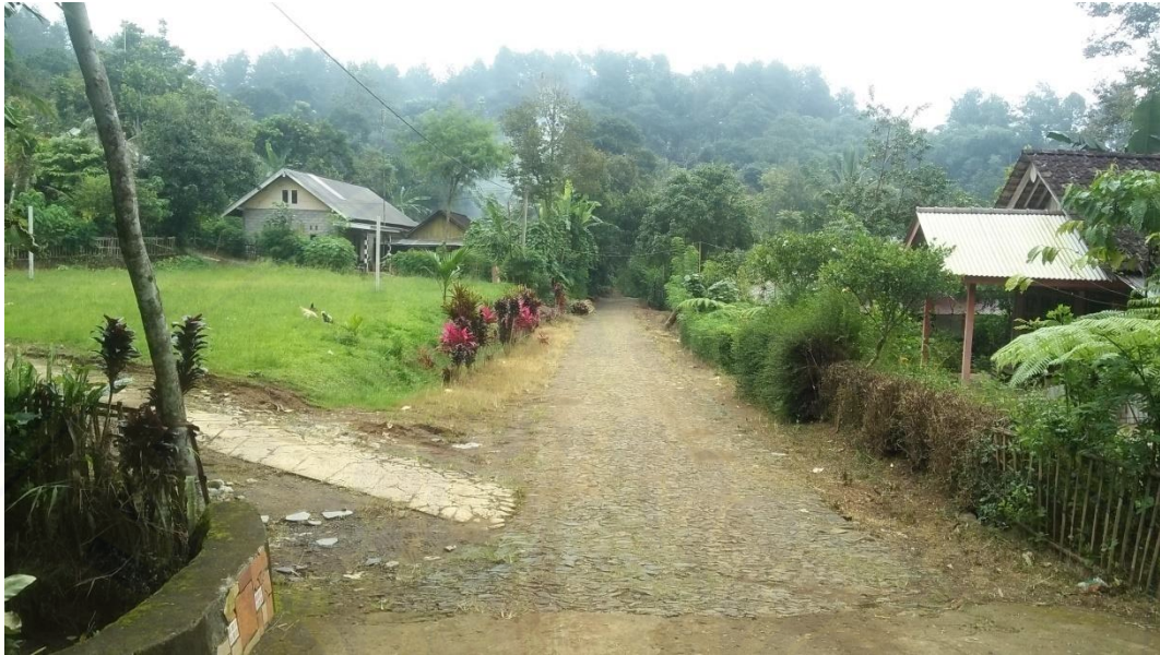
Kondisi rumah pemukiman yang ada di Desa Nglurup Tulungagung.
