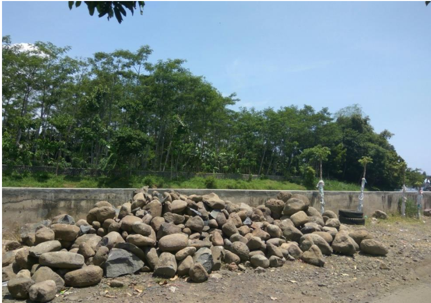
Gambanr pembangunan plengsengan di Kecamatan Besuki
