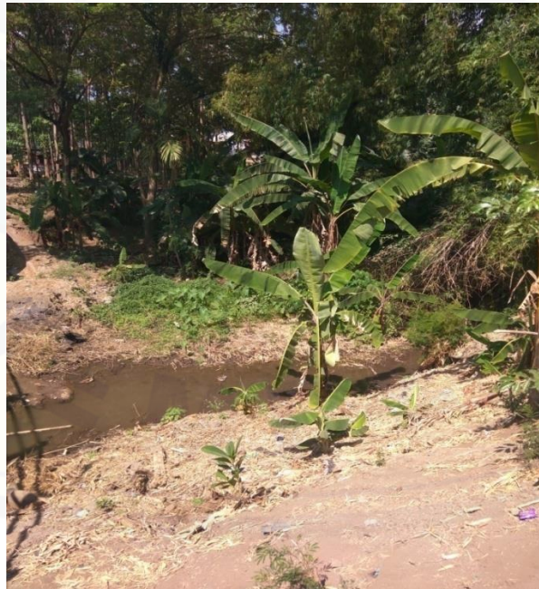
Gambar Sungai yang belum dibangun plengsengan
