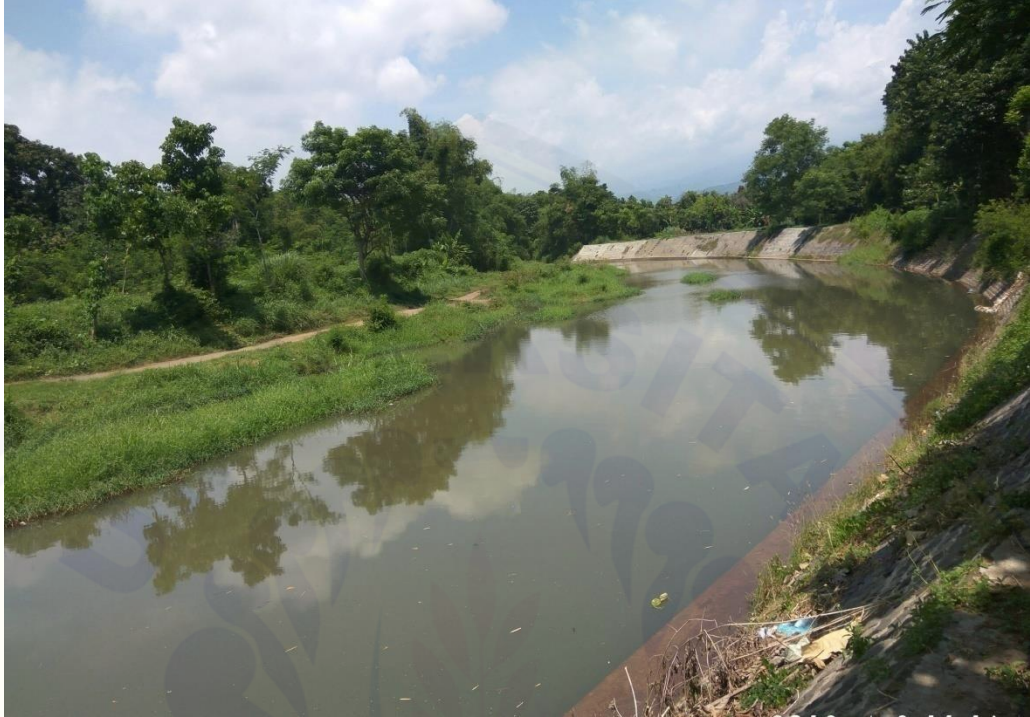
Gambar plengsengan yang telah dibangun dan yang sebelah kiri belum dibangun di Kecamatan Besuki
