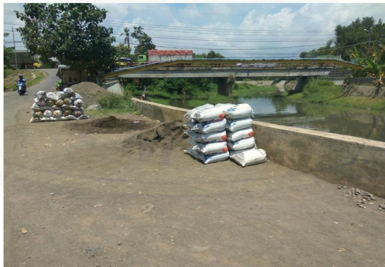
Gamabar pembangunan plengsengan di Kecamatan Besuki
