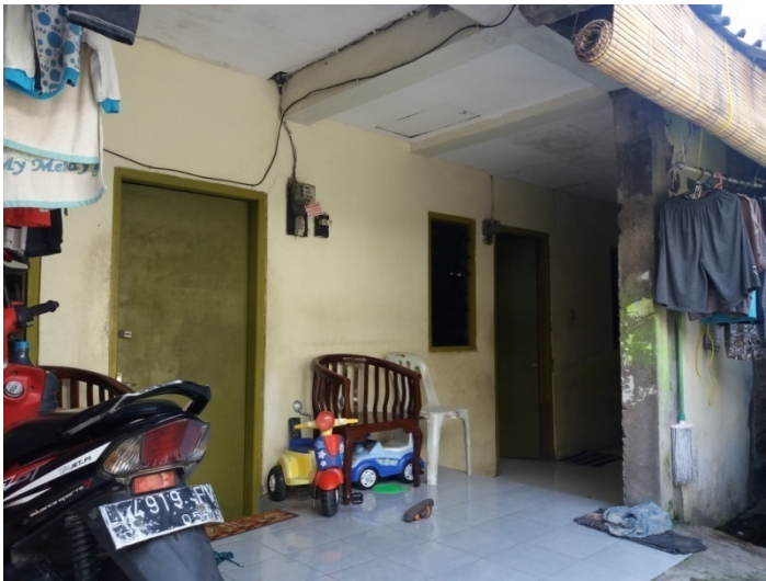
Foto Kondisi rumah kost yang berada di Rumgkut.
