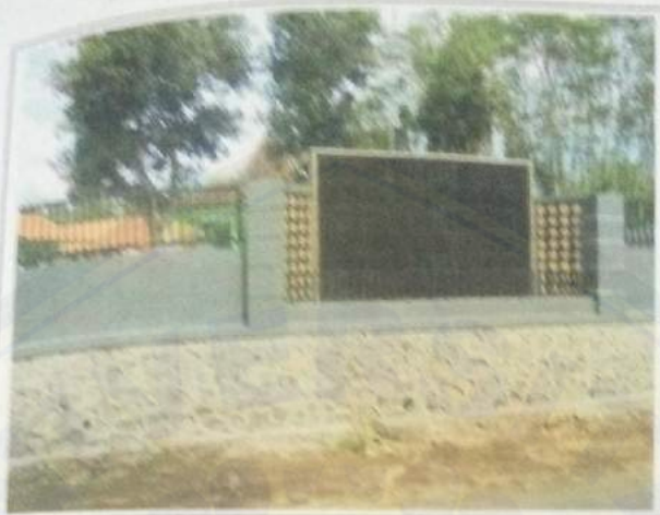
FOTO 100% REHAB PAGAR & GAPURA KANTOR DESA INISUN DUK LENGKONG DESA SUMBER WRINGIN
