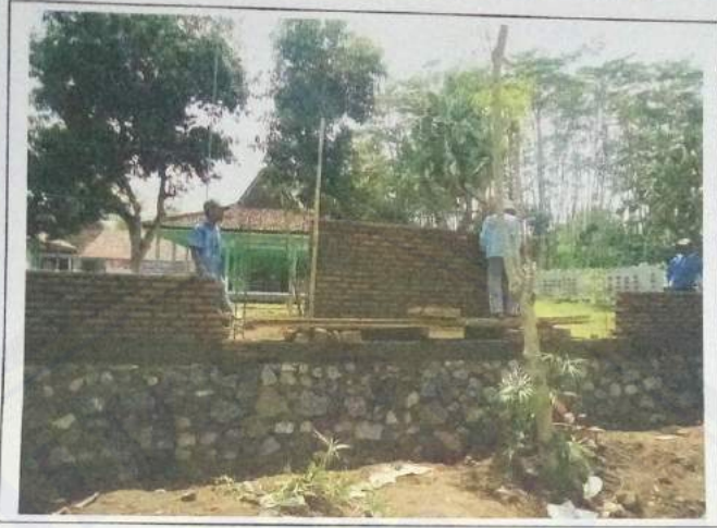
FOTO PAS. BATA REHAB PAGAR & GAPURA KANTOR DESA DUSUN DUK LENGKONG DESA SUMBER WRINGIN
