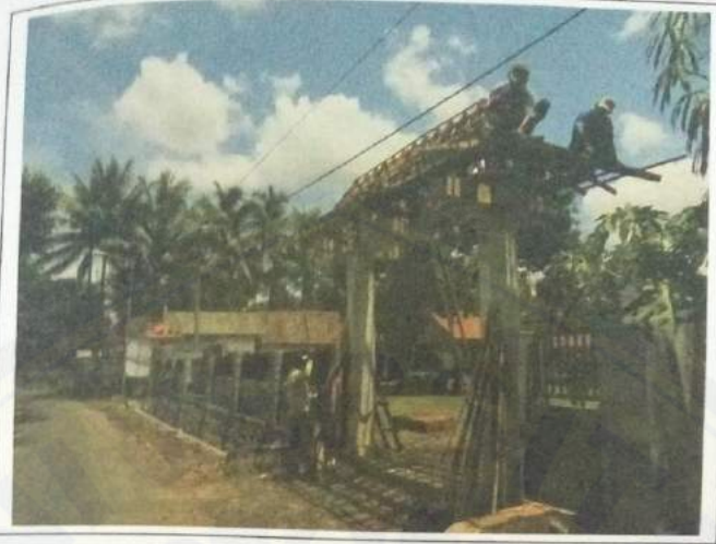
FOTO PEKERJAAN PAGAR & CAT-CATAN DUSUN DUK LENGKONG DESA SUMBER WRINGIN
