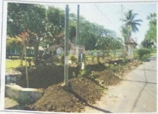
FOTO PEK. GALIAN REHAB PAGAR & GAPURA KANTOR DESA DUSUN DUK LENGKONG DESA SUMBER WRINGIN
