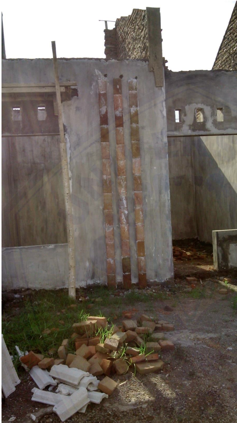
Gambar Setelah Benangan/Plesteran/Benagan/Tembok
