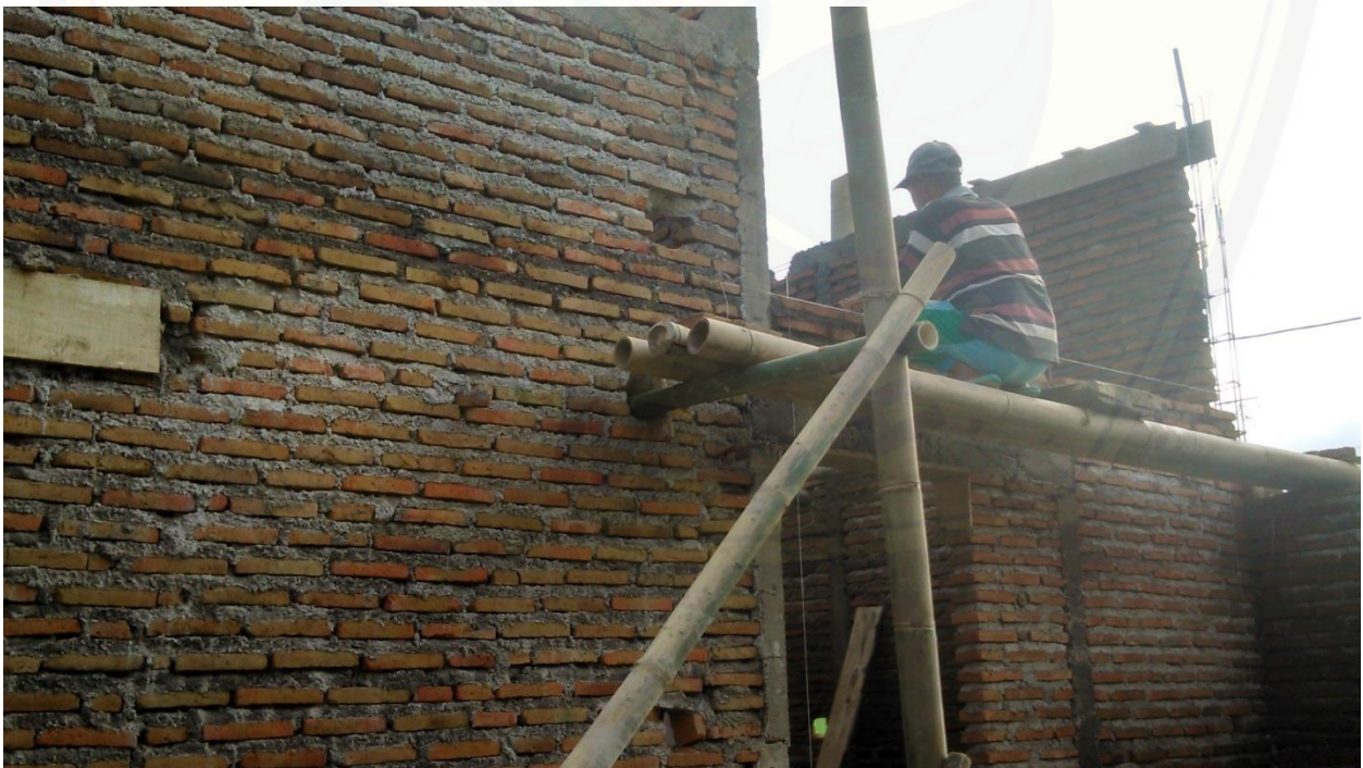
Kegiatan Pemasangan Batu Merah Tahap Atas dan Persiapan Membuat Beton Ring
