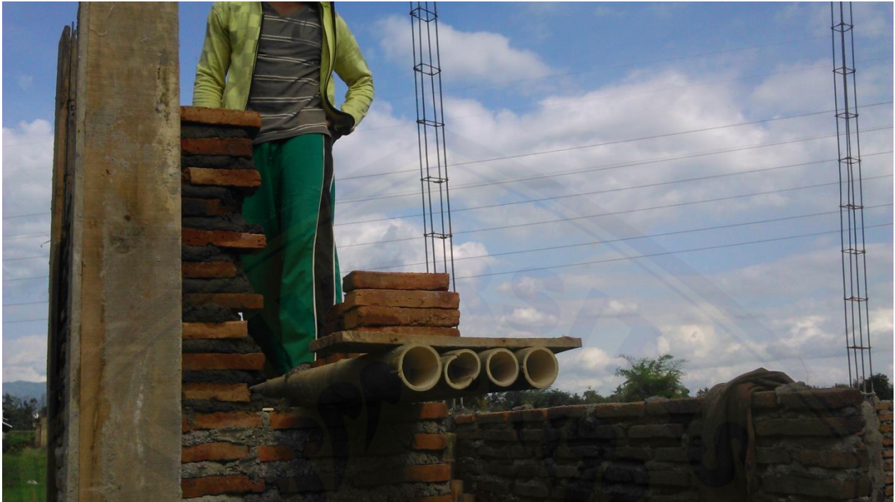
Kegiatan Pemasangan Batu Merah Tahap Atas dan Persiapan Membuat Beton Ring
